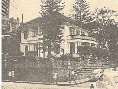
Figura 25. Sede localizada na Rua Visconde de Ouro Preto.
